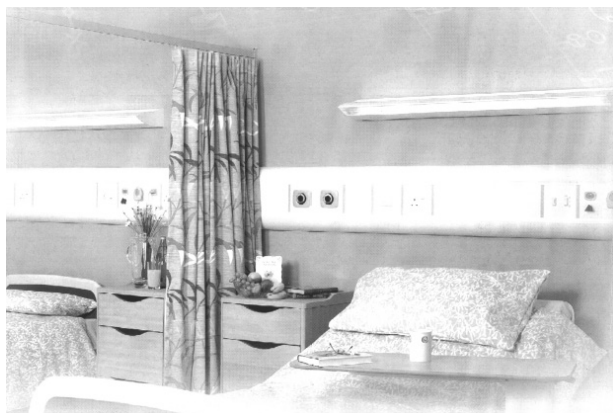
圖3-3：病房電線槽裝置
