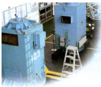
圖4-1：水務署高壓摩打維修工場
