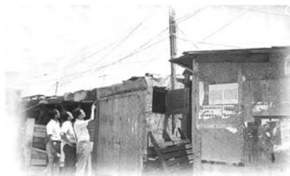
圖1-1：早期村屋供電前測試
