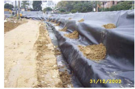
Plate 5: Concrete toe pour
