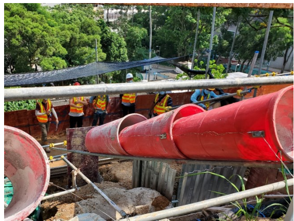
(d) Placement of SCM by chutes
