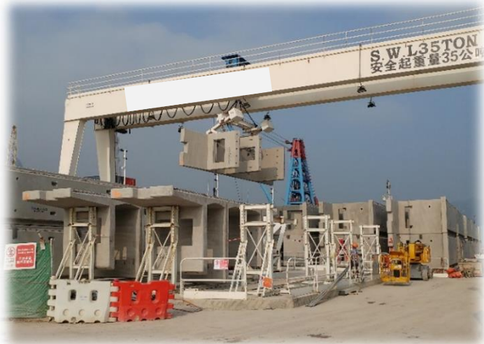
使用特製吊運夾吊運預制件
