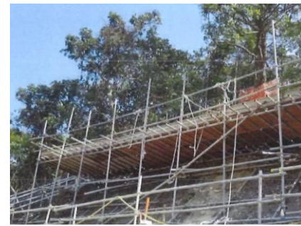
搭建棚架 (防墮措施)
