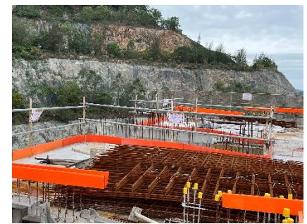
樓邊工作 (護欄及踢腳板)
