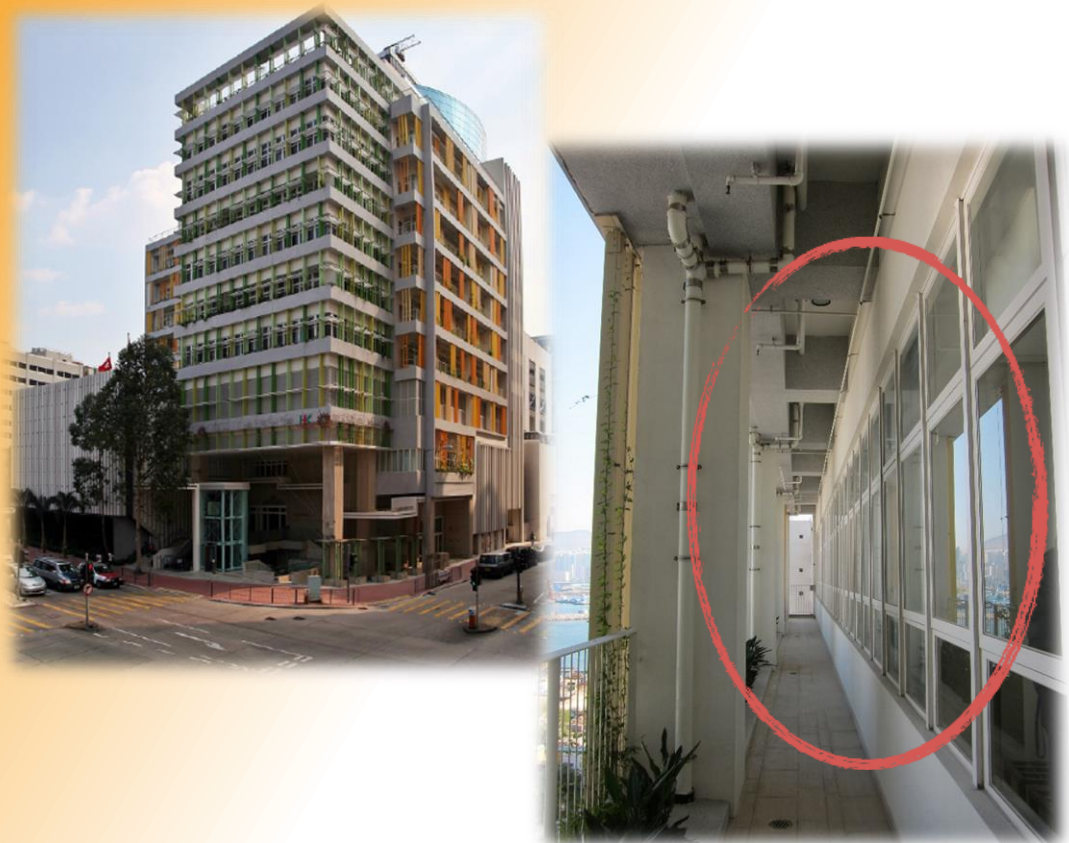
土瓜灣填海區庇利街聯用 綜合大樓建造工程 外牆維修走廊
