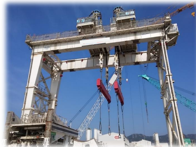
使用吊樑吊運預制件
