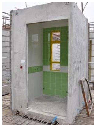
Precast toilet unit
