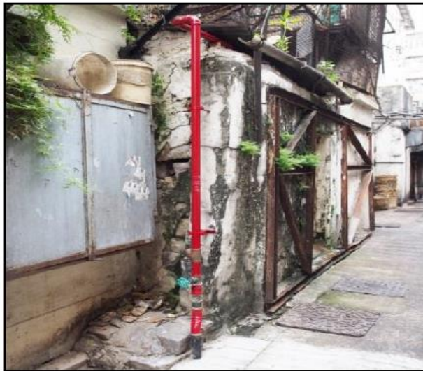
由街喉直接供水的折衷式喉轆系統
