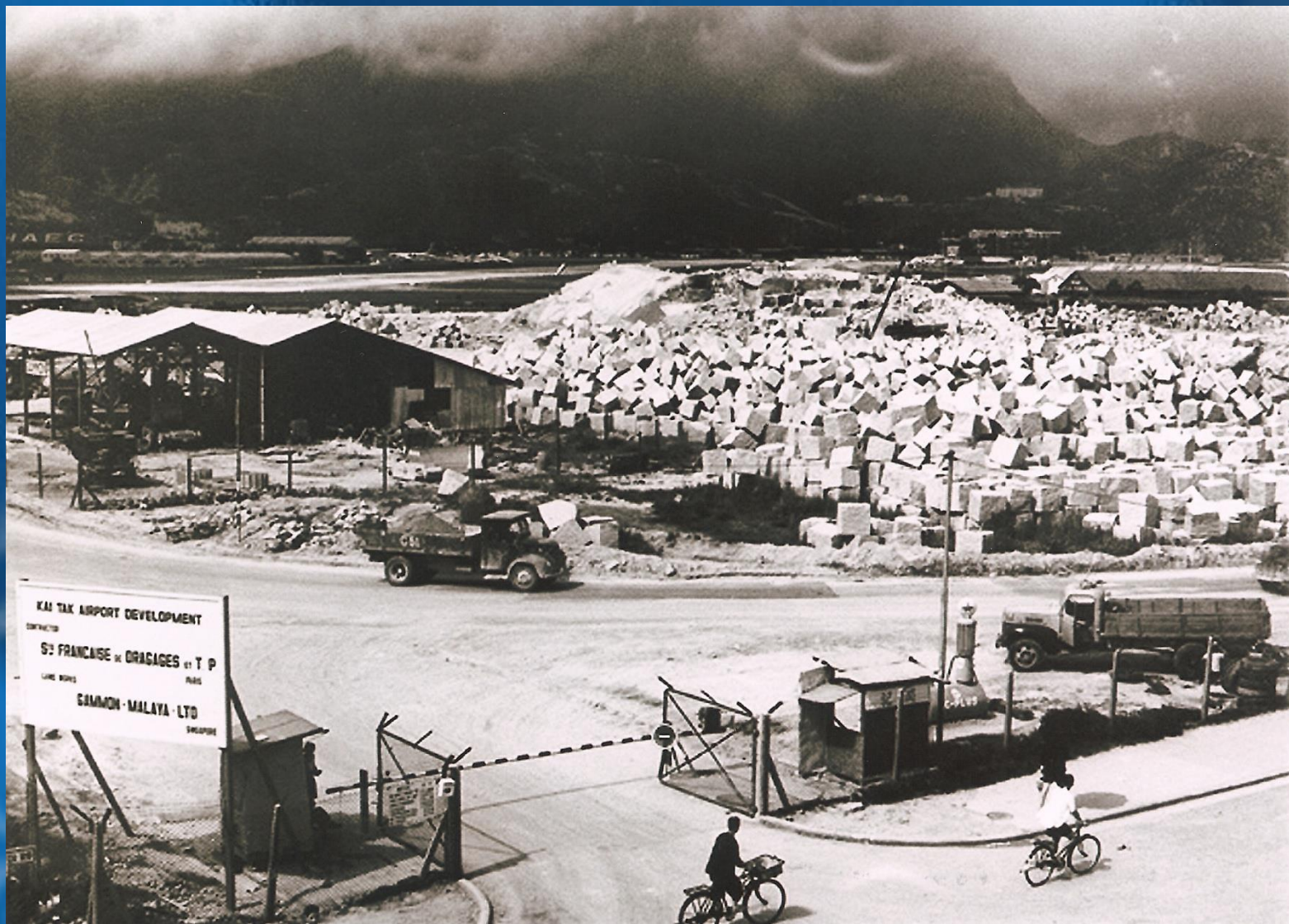
1956年位於宋皇臺道寶嘉公司建築地盤入口，可見門前寫有法國寶嘉公司及金門(馬來亞)公司名稱的告示牌。圖右可見聖山差不多被移平，臨時放置於聖山前的呈方體石塊，採自安達臣道礦石場，等候興建海堤之用。
