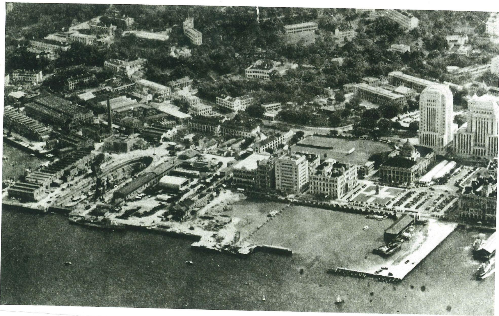
正在填海的平諾道中，1952年。完成後為大會堂所在的愛丁堡廣場。
