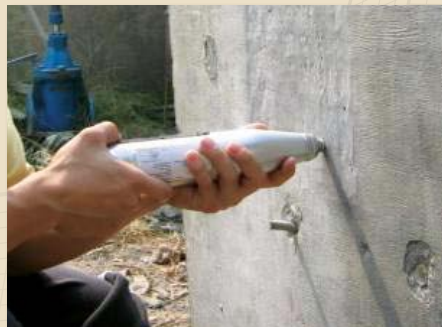
混凝土回彈(打槍)測試
