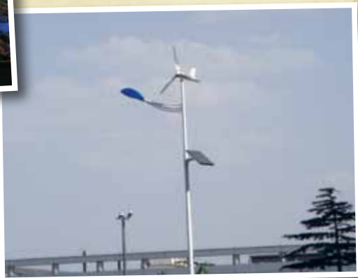
在天津高新區所見的風力及太陽能發電路燈
